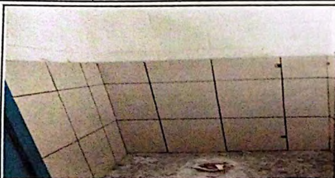
Sustitución de inodoro
