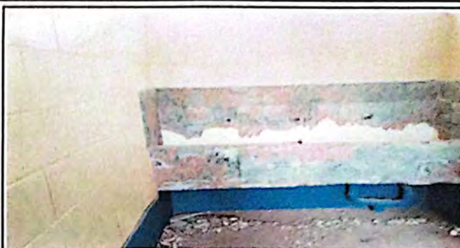
sustitución de azulejos
