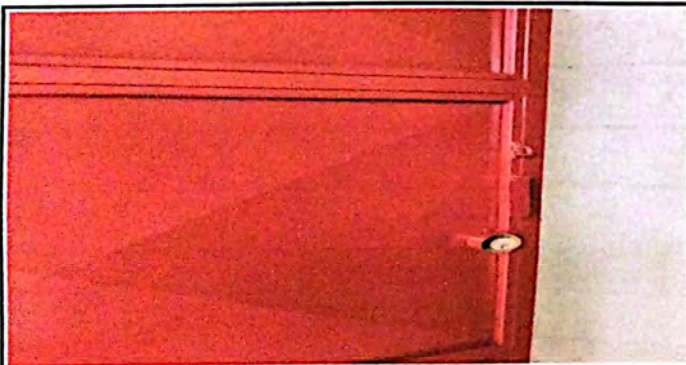
Mantenimiento de estructura de puerta de metal
