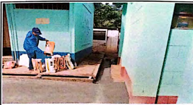
Mejoramiento de plancha de concreto de patio.
