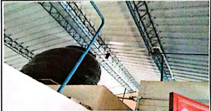
sustitucion de accesorios de deposito de agua
