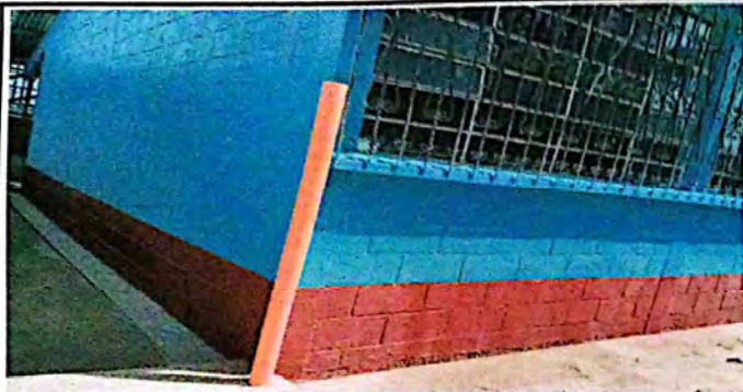
Pintura de muros exteriores e interiores
