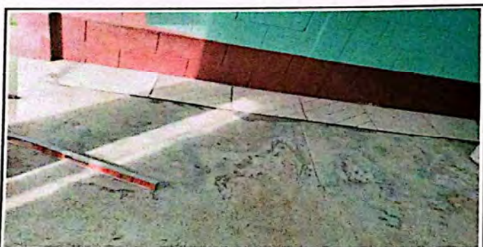
Sustitucion de piso ceramico
