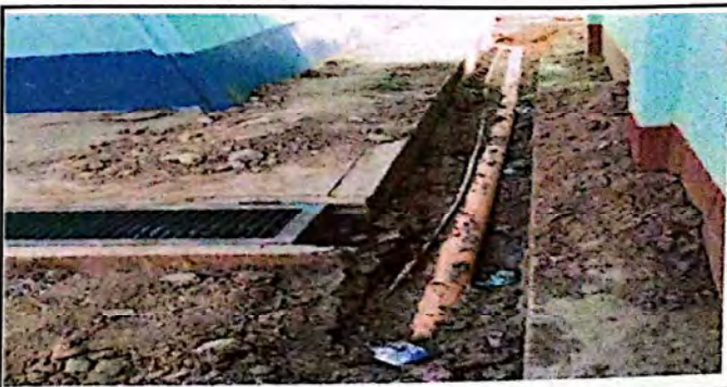
Reparacion de red de agua potable
