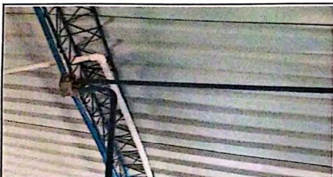
Reparacion de sisema electrico ( cable, focos, ducto electrico y accesorios)
